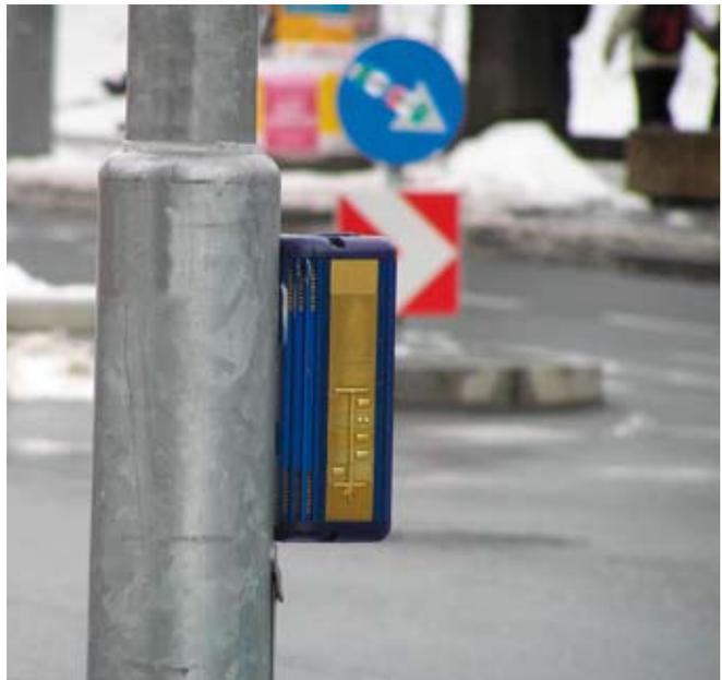
Abb. 12: Akustischer Signalgeber für Blinde bzw. Sehbehinderte Fußgänger. Zusatzinformation zur örtlichen Situation ist direkt am Gerät ertastbar.
