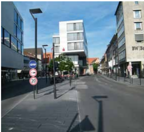
Deutschland, Ulm, Neue Straße Beginn des umgestalteten Bereiches
